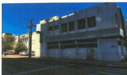
TESTADA DO LOTE PELA RUA SALDANHA MARINHO
