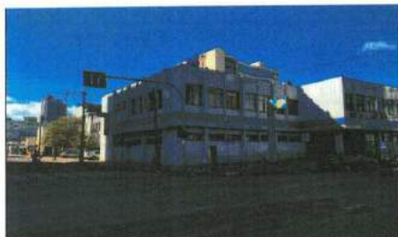
VISTA DO LOTE (ESQUINA)
