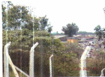
Figura 4: Vista Centro-Sudeste (matr. 101.215).
